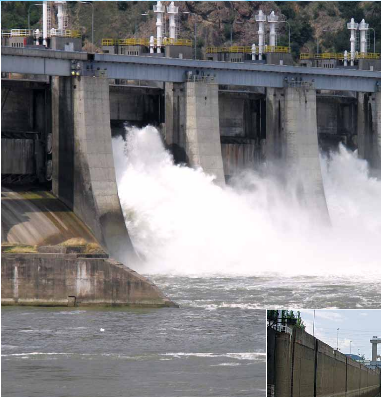
Prelivna polja brane – hidraulična instalacije dvostrukih kukastih zatvarača
