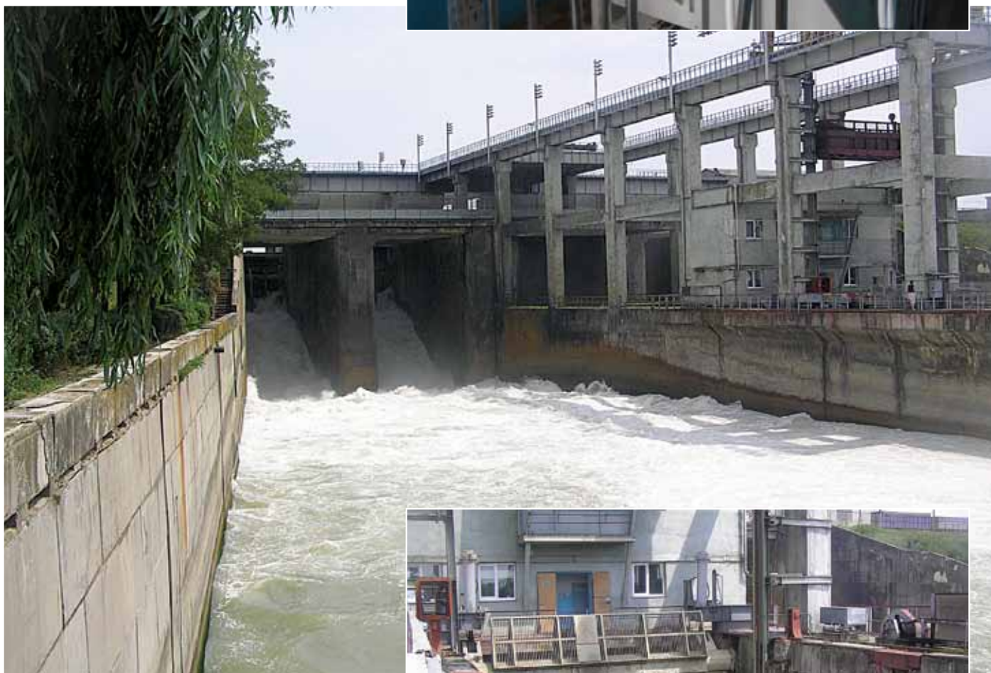
Prvi i drugi otvor vodopropusnog objekta
