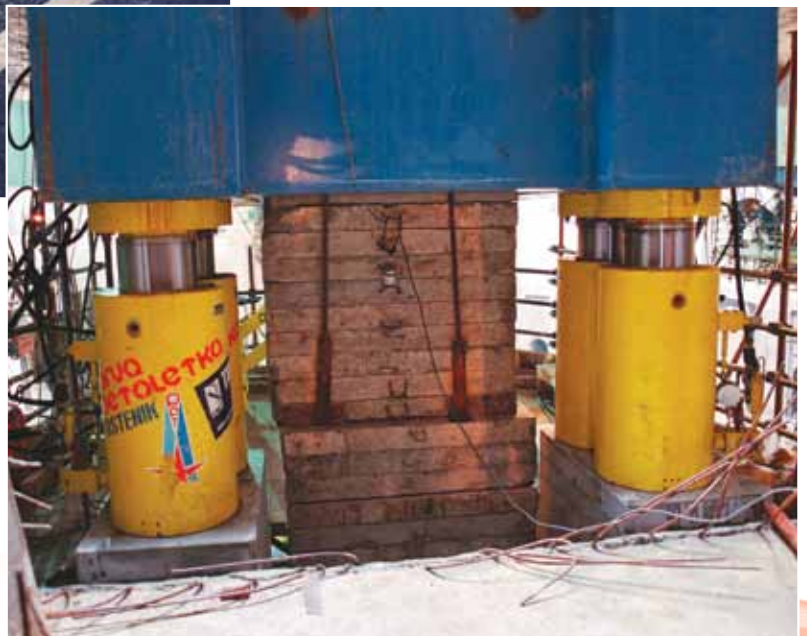
Princip podizanja kupole Hrama Svetog Save
