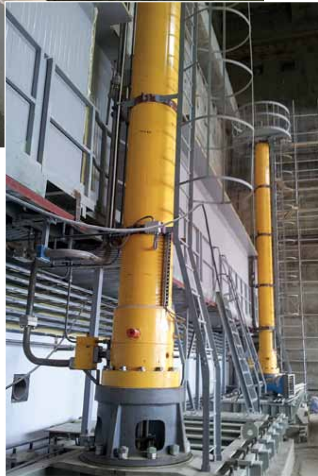
Kupac: Trust Gidromontaž, Rusija Isporuka: 2011. godina Elektrohidraulični sistem za pogon 4 brza predturbinska zatvarača.
