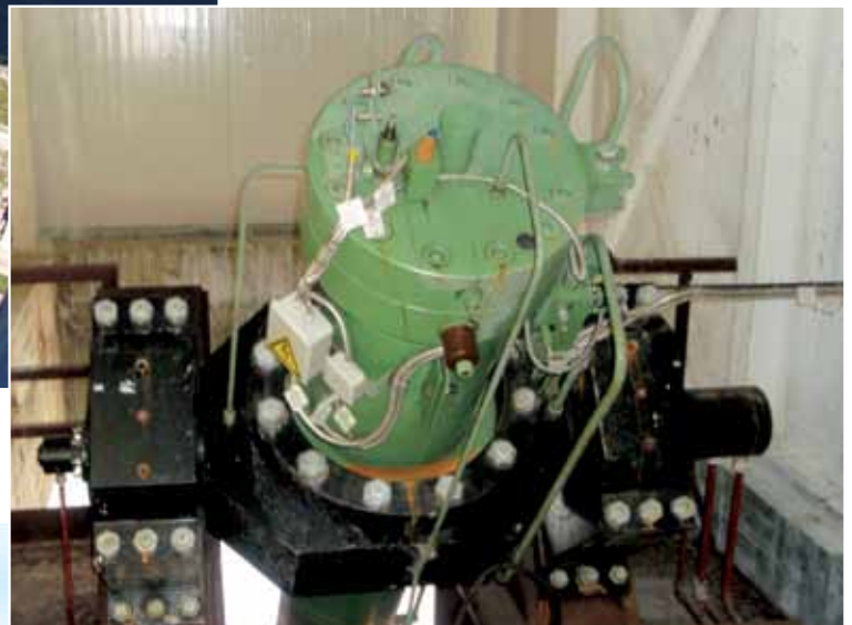
Cilindar segmentnog zatvarača prelivnog polja s osloncem i upravljačkim blokom
