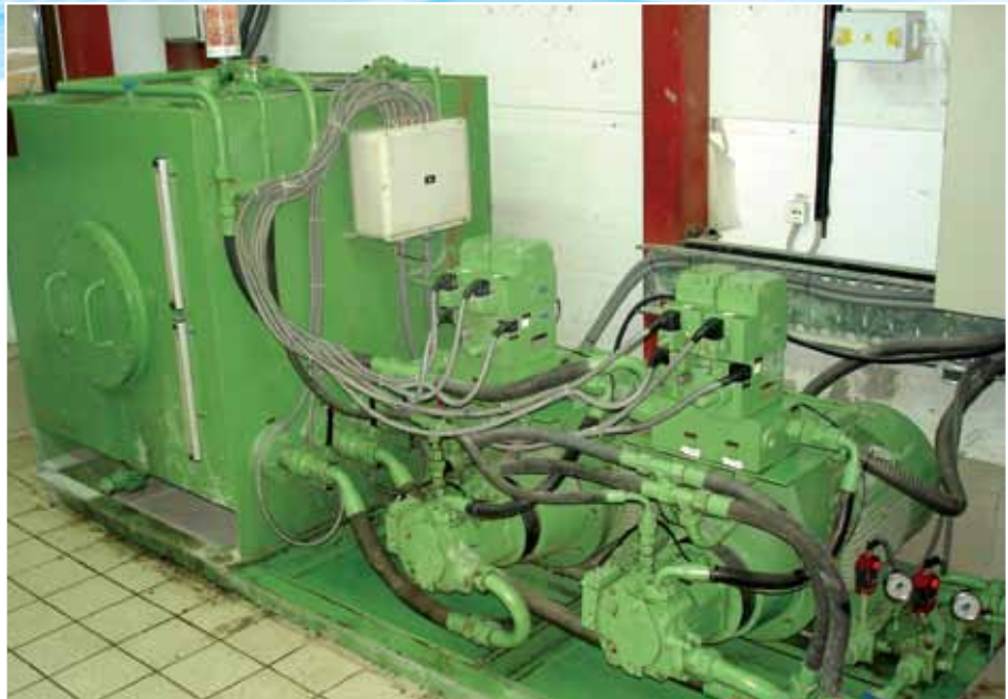
Hidraulični cilindri tablastog i segmentnog zatvarača
