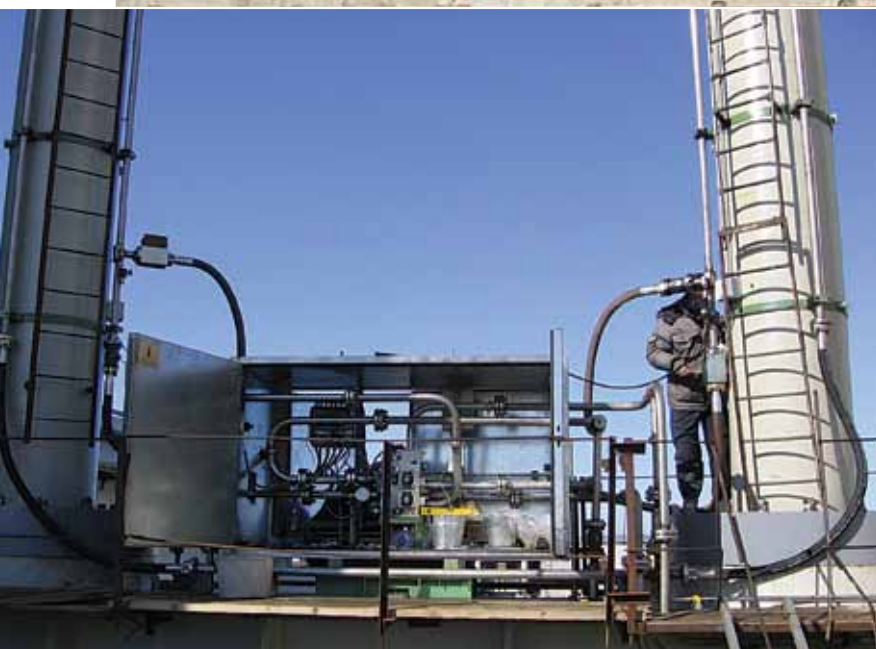
Upravljački blok za sinhronizaciju rada cilindara leve i desne strane zatvarača
