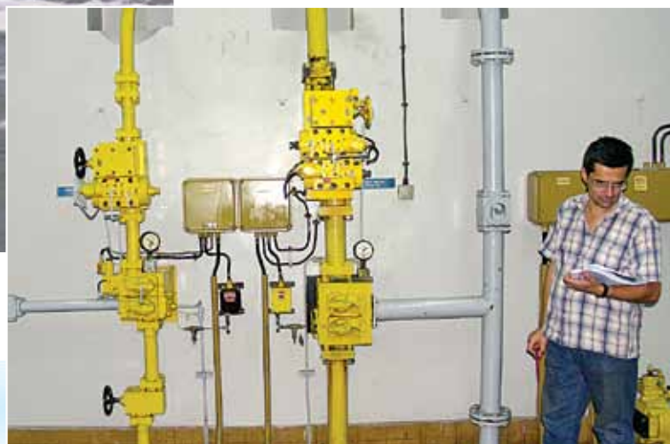
Đerdap 1 – Upravljački blokovi na srednjoj glavi brodske prevodnice
