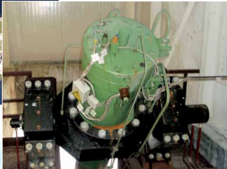
Цилиндр сегментного затвора водослива с опорой и блоком управления
