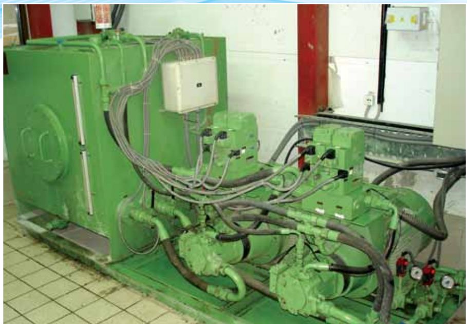
Гидравлические цилиндры плоского сегментного затвора
