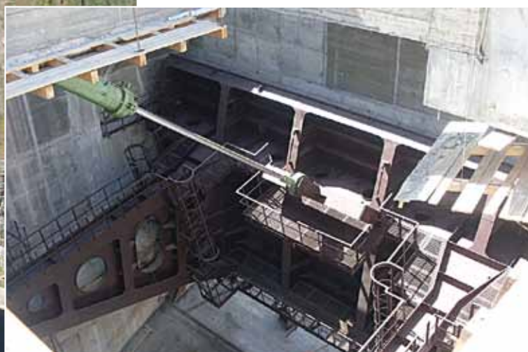
Цилиндр сегментного затвора водослива
