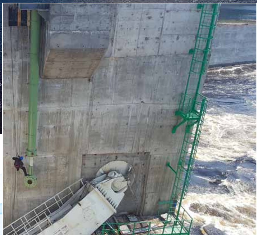
Цилиндр сегментного затвора
