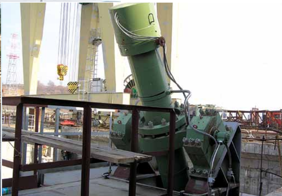
Цилиндр сегментного затвора с опорой
